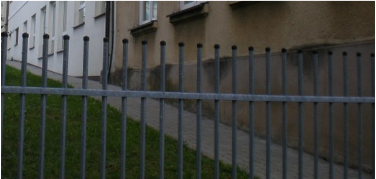
Ilustracja 5: ZAWILGOCENIE COKOŁU (ELEWACJA POŁUDNIOWO- ZACHODNIA)
