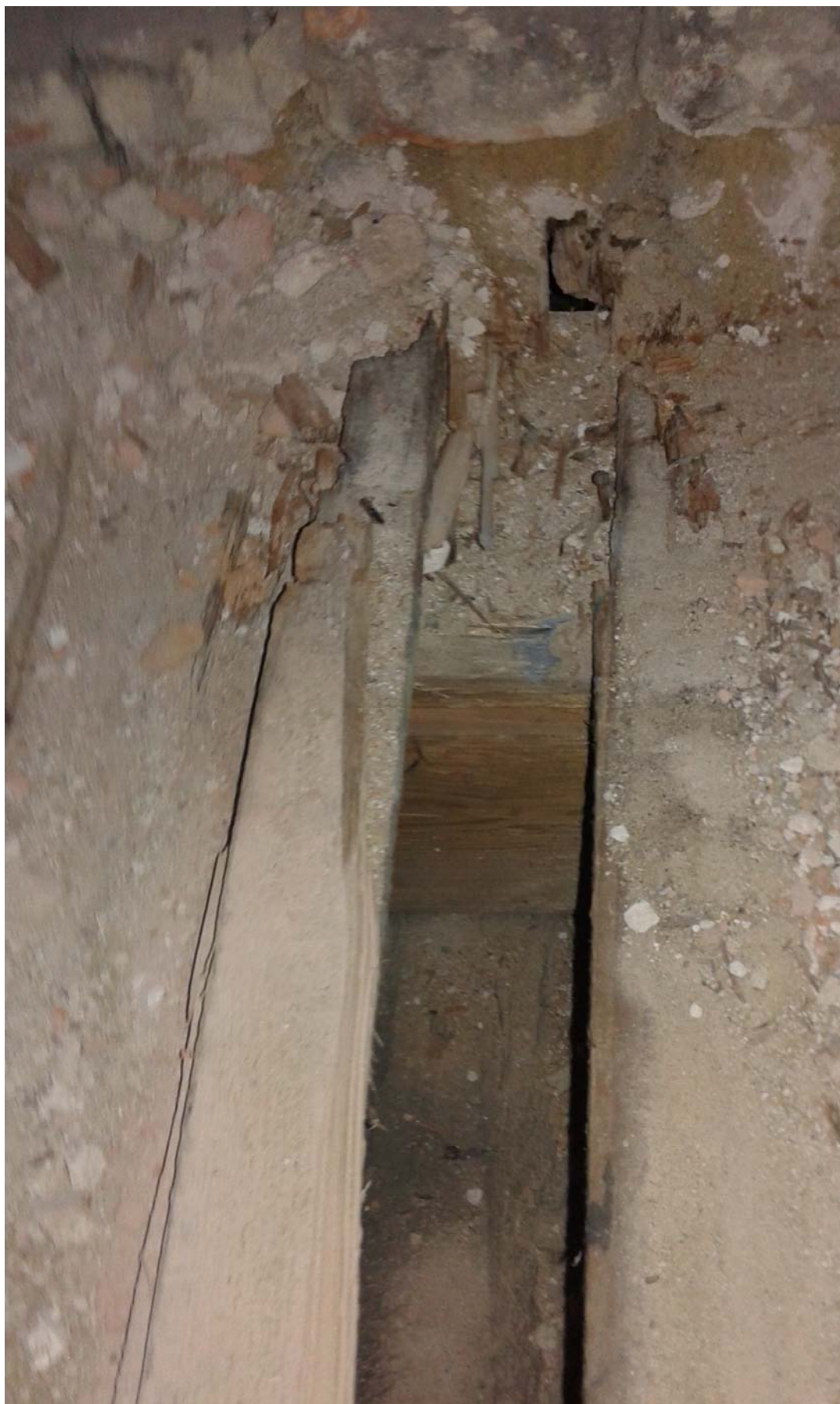
Fot. 5. Widok odkrytej belki stropowej.
