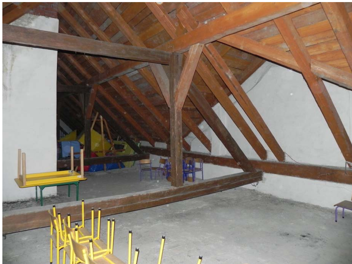
Fot. 4. Istniejąca konstrukcja dachu
