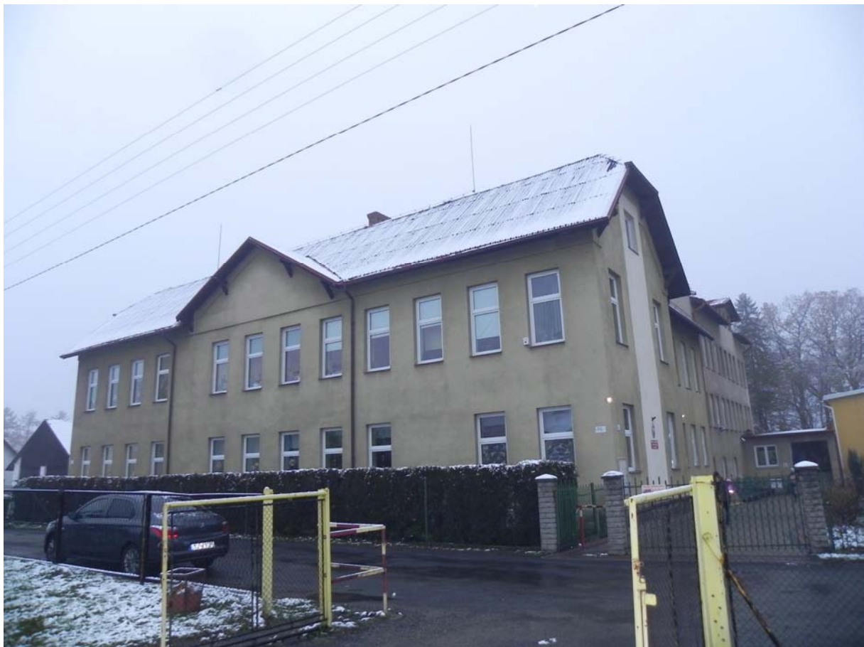
Fot.1. Widok ogólny budynku od strony części przebudowywanej.
