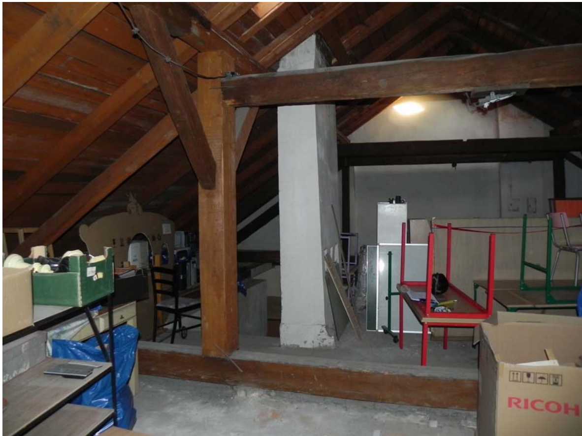
Fot. 3. Istniejąca konstrukcja dachu.
