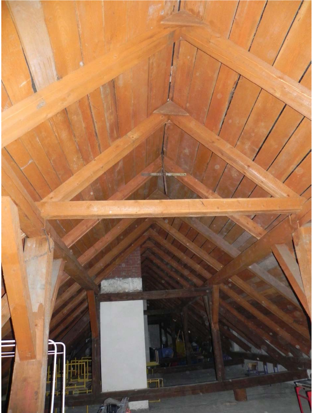
Fot.2. Istniejąca konstrukcja drewniana dachu.
