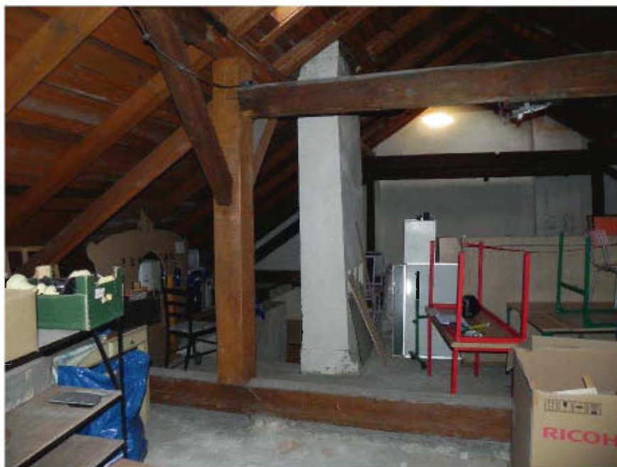
Fot. 3. Istniejąca konstrukcja dachu.
