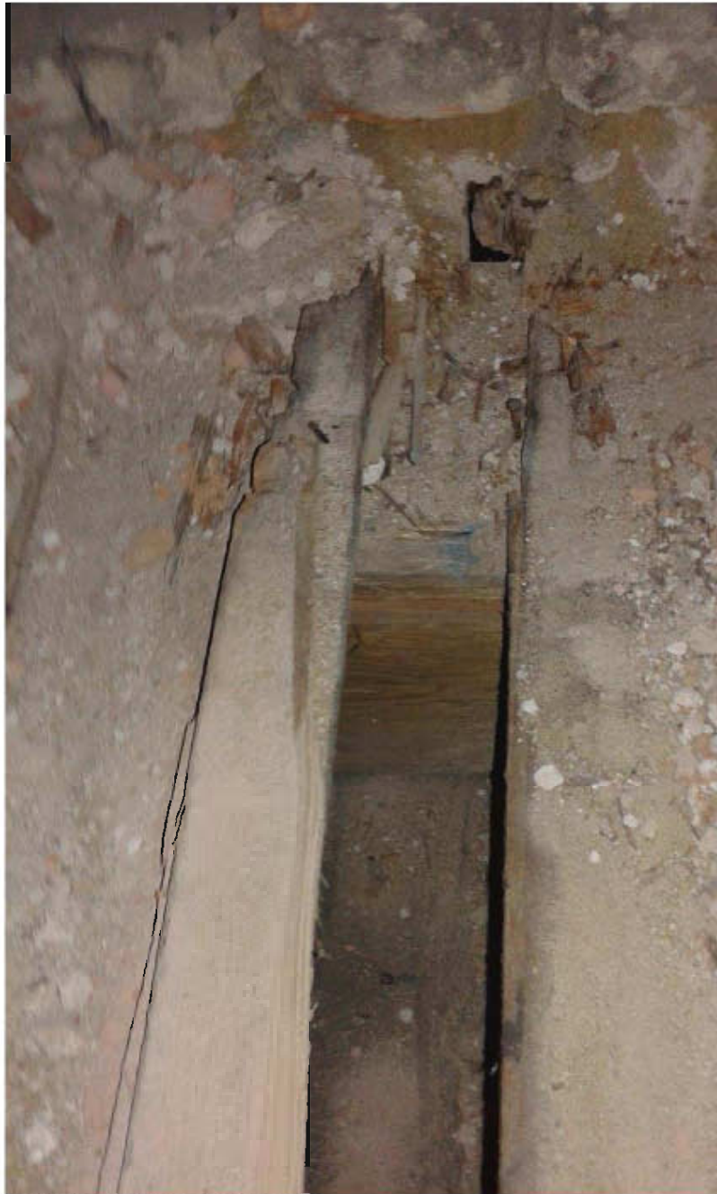
Fot. 5. Widok odkrytej belki stropowej.
