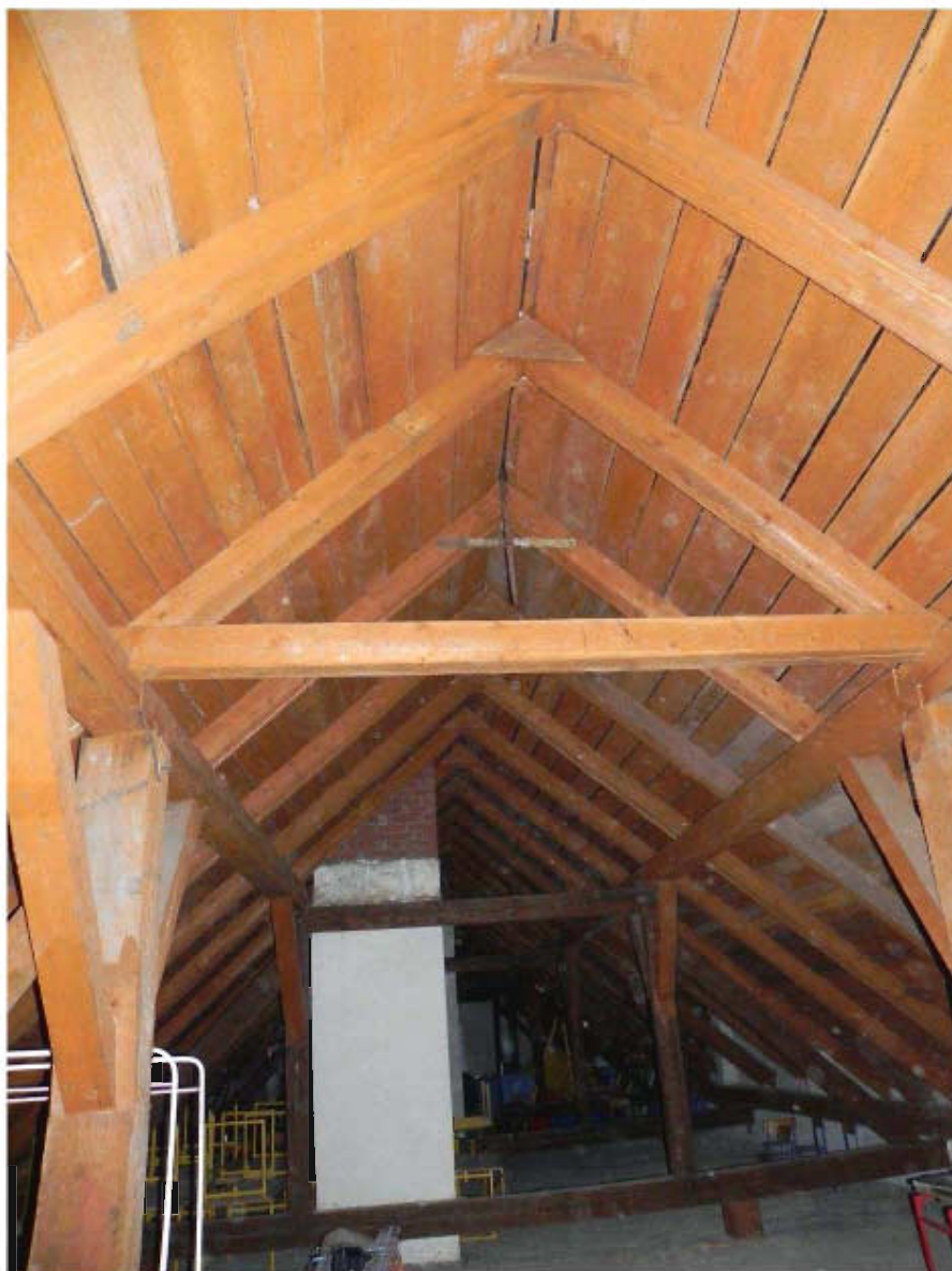
Fot.2. Istniejąca konstrukcja drewniana dachu.
