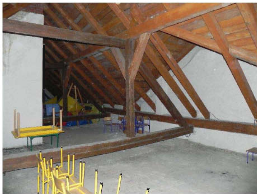
Fot. 4. Istniejąca konstrukcja dachu
