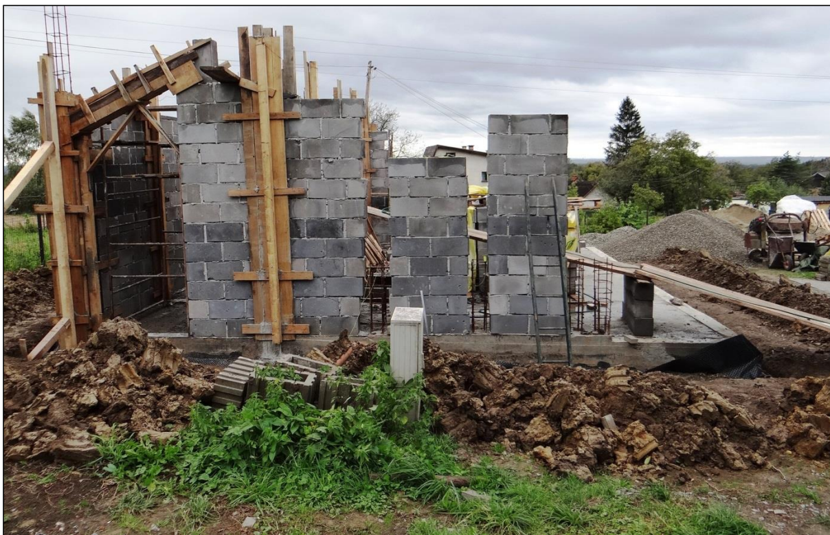
Budowa zadaszonej sceny wraz z zapleczem w Zamarskach
