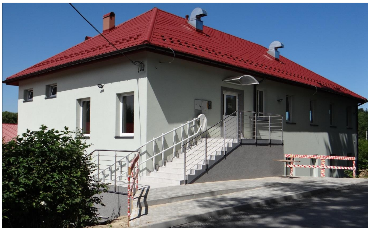
Dom Sportowców w Kończycach Wielkich, w którym znajduje się świetlica wiejska, wyposażona w sprzęt zakupiony w ramach Konkursu Przedsięwzięć Inicjatyw Lokalnych
