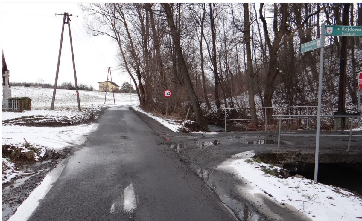
Przebudowana ulica Rudowska w Zamarskach
