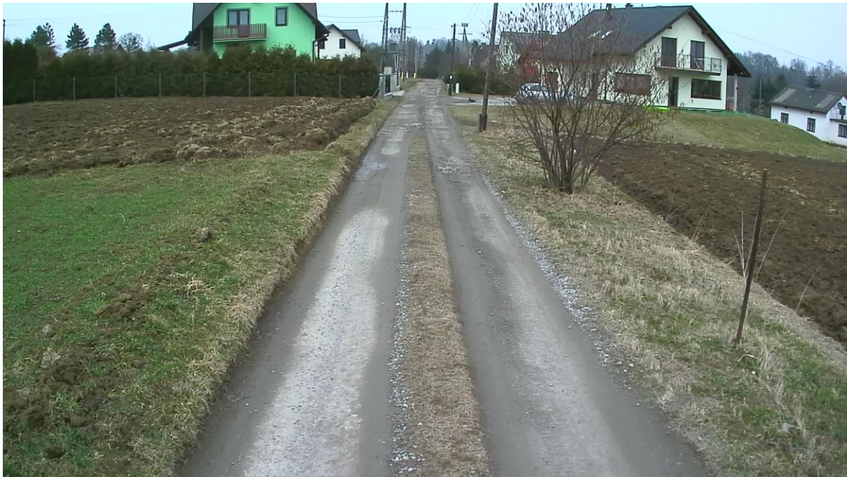
Ul. Zagrodowa w Hażlachu przed przebudową
