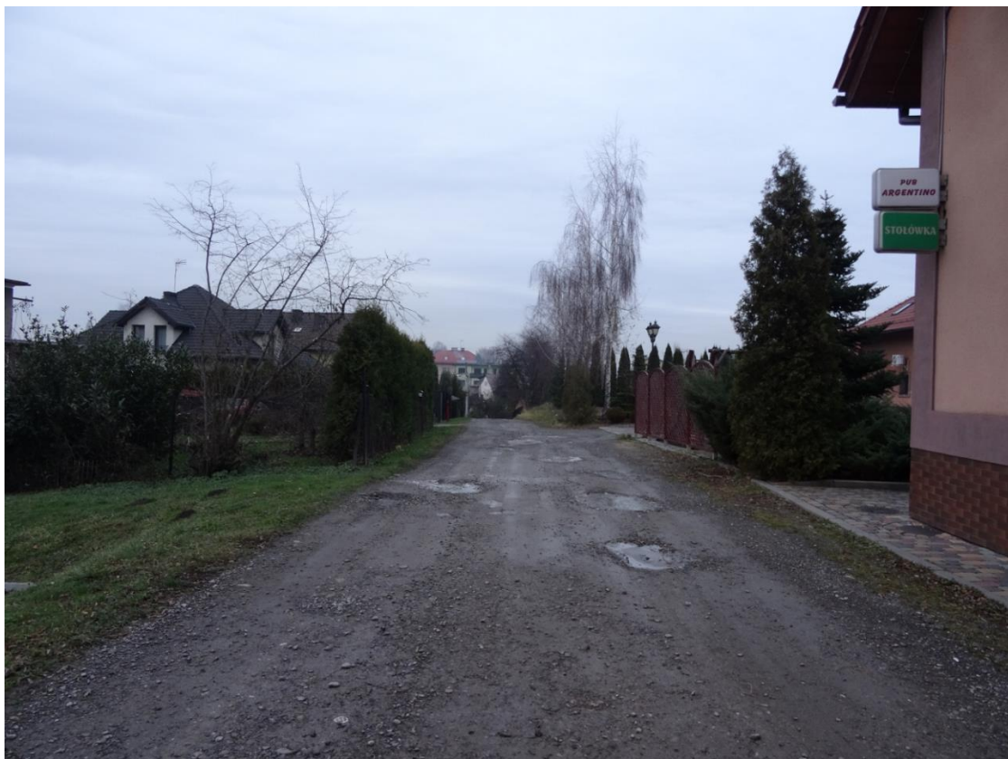
Ul. Dworska w Pogwizdowie przed przebudową
