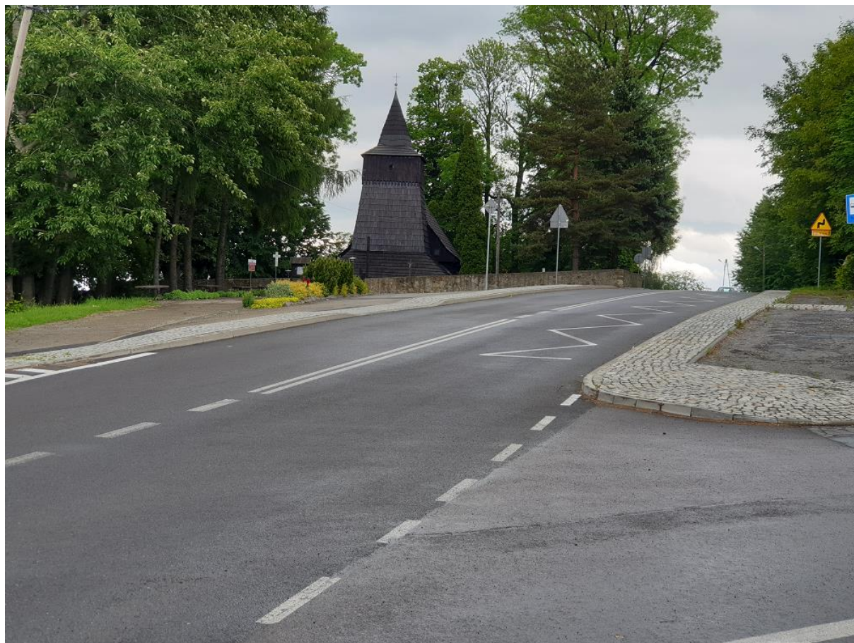
Remont istniejącego pobocza w Zamarskach przy ul. Cieszyńskiej
