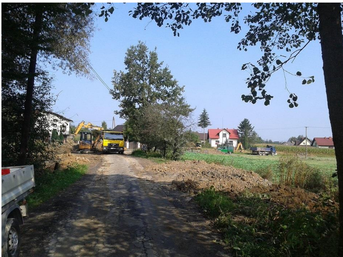
Budowa kanalizacji na ul. Rudowskiej
