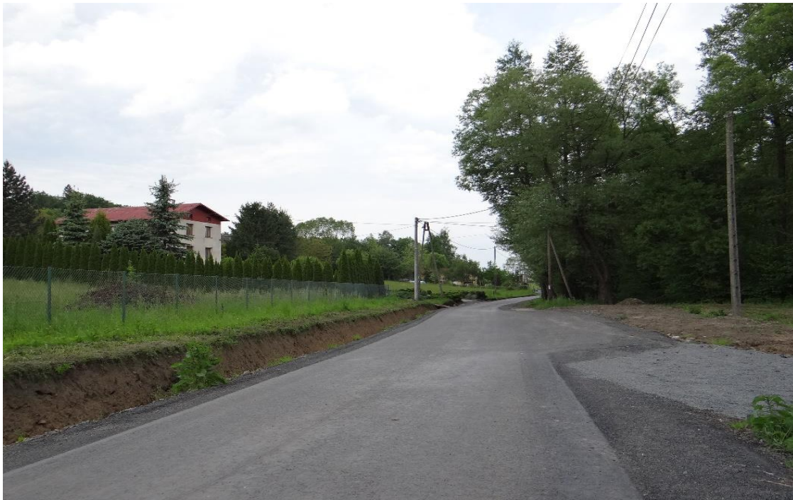
Ul. Rudowska po przebudowie
