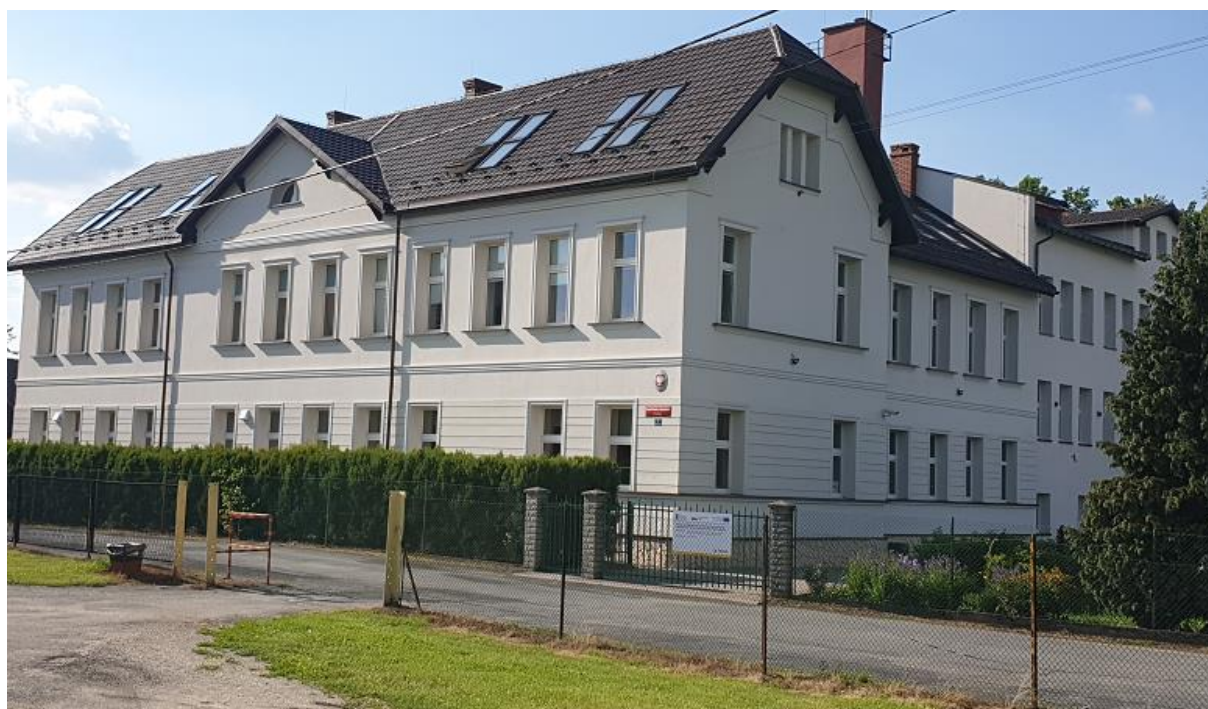
Szkoła w Hażlachu po termomodernizacji
