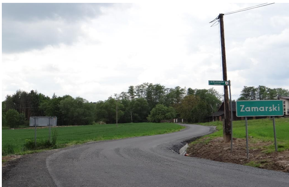
Ul. Rudowska po przebudowie
