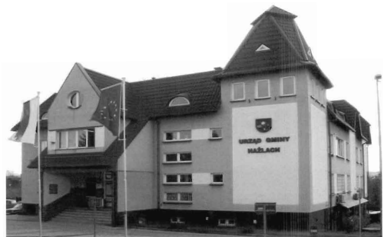
Budynek Urzędu Gminy Hażlach
